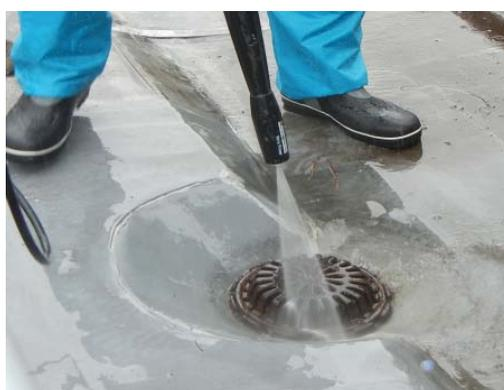
写真1 高圧洗浄機による屋上排水口の洗浄の様子
